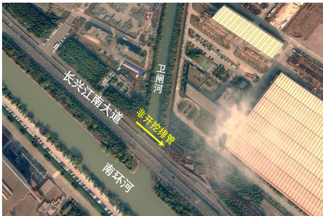
图 1.7-3 排管跨越卫闸河
