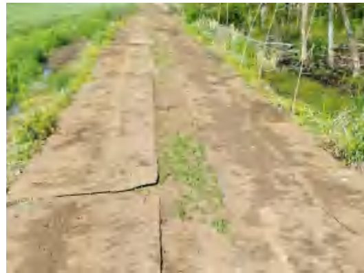
临时施工道路铺设钢板
