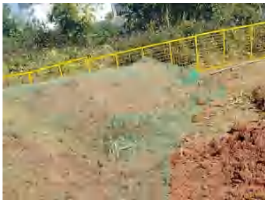
临时堆土苫盖
