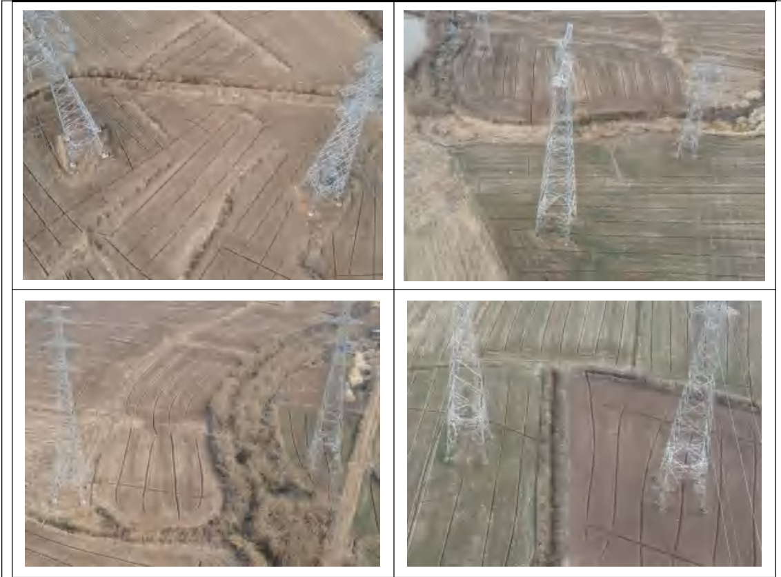
图 8-1 塔基土地平整及生态恢复情况
