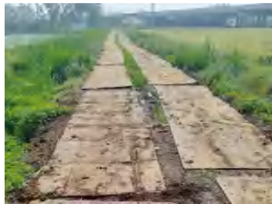
临时施工道路铺设钢板
