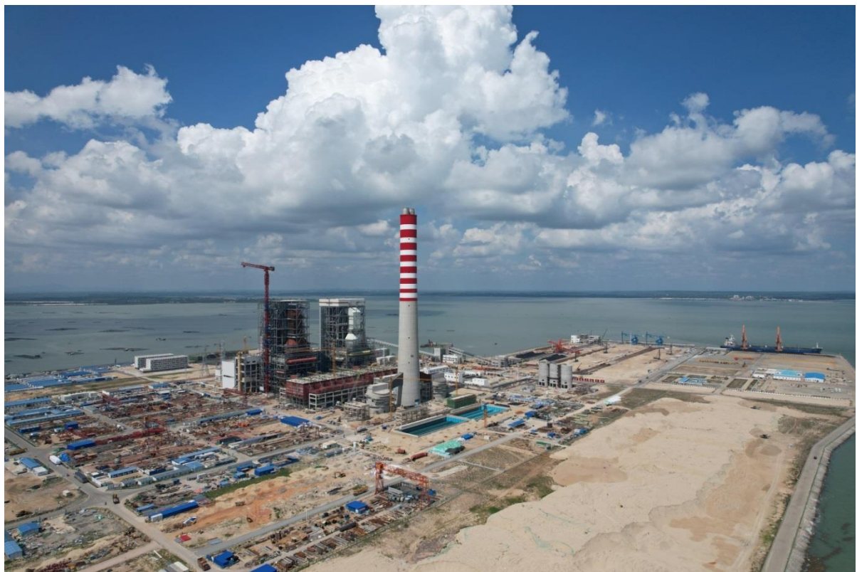
照片 1.3-1 国能广投北海电厂现状
