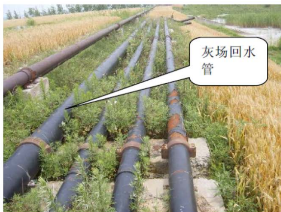
图 3.1-10 青年闸灰场回水回用系统
