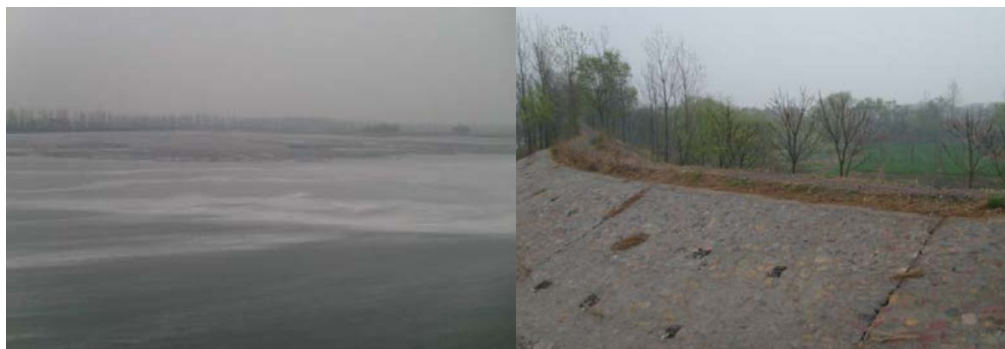
图3.1-11 谢大郢子渣场拦渣坝
