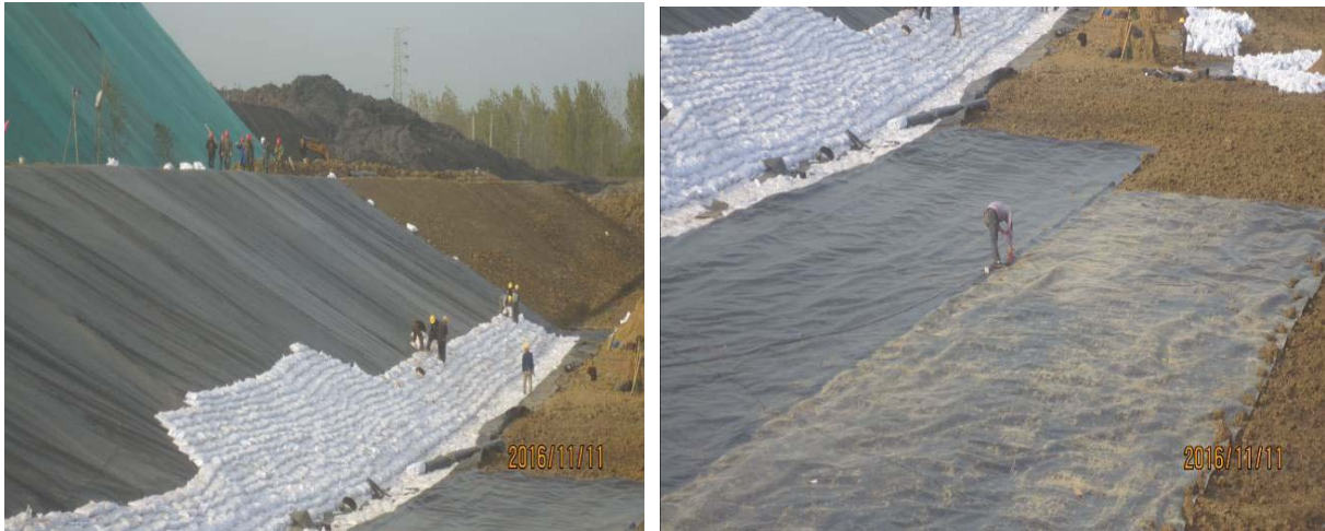
图3.1-11 潘一灰场（三期灰场）灰坝和灰场底部铺设防渗膜
